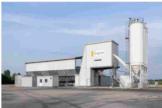
L'impianto Lonato Due recentemente realizzato da Concrete Italia (Bs).
